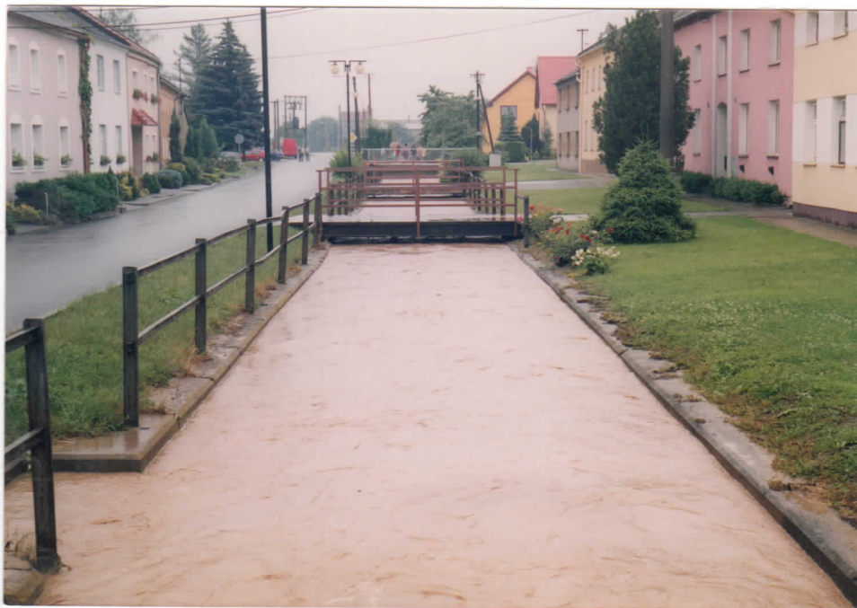
Obr.7 Povodeň 11.6.2008, potok Blata, Senice na Hané, ul. Vodní Výpočtový profil, S = 6,0\text{m}^2 , I = 0,4\% , n = 0,030 , v = 2,0\text{m/s} , Q = 12\text{m}^3/\text{s} .
