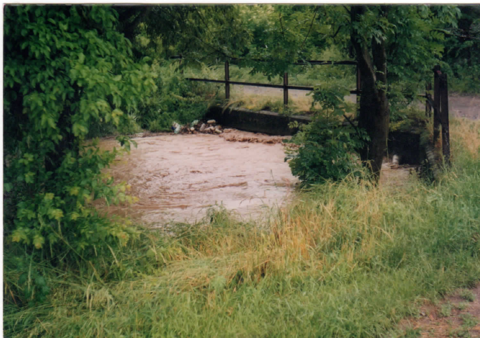
Obr.8 Povodeň 11.6.2008, potok Blata, most nad Senicí na Hané. Úroveň hladiny při Q = 12\text{ m}^3/\text{s}
